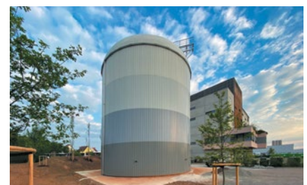
Der fertiggestellte Wärmespeicher mit Begrünung
